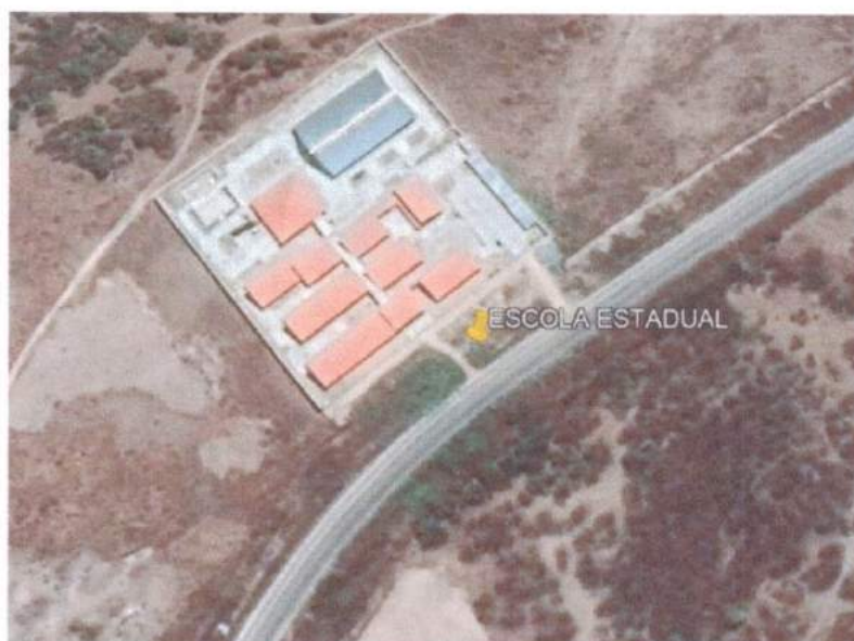
Figura 1: Vista aérea do trecho a ser intervindo
